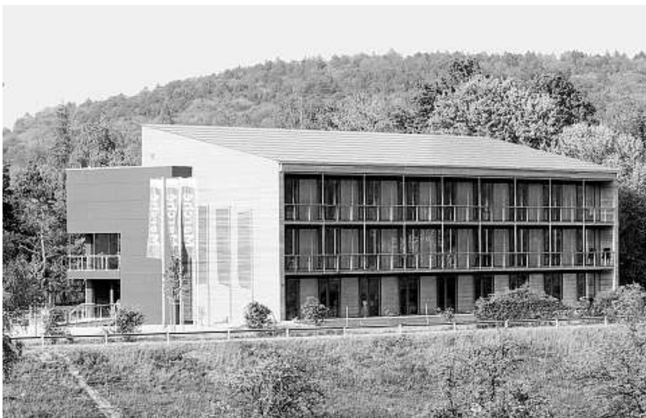
Magnet für Touristen: Von aussen ist dem Nullenergie-Bürogebäude seine Besonderheit nicht anzusehen.
