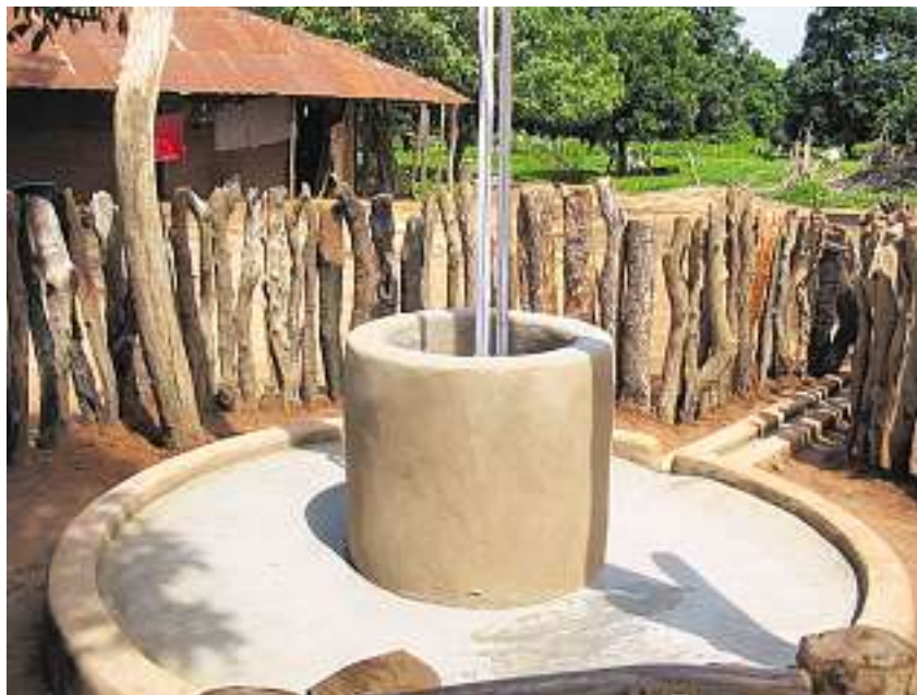
... wird der Bau von Brunnen in Guinea-Bissau unterstützt.
