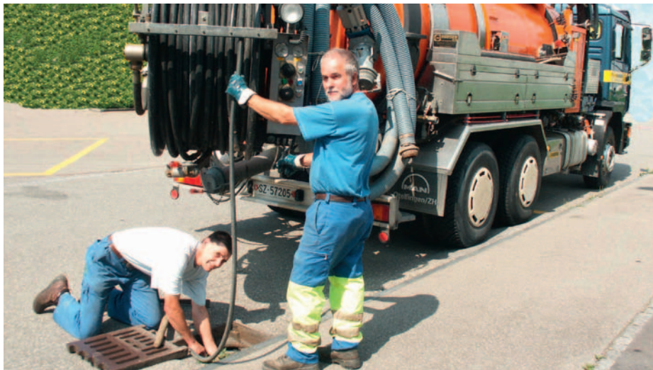
Eine Kanalisation wird durchgespült.
