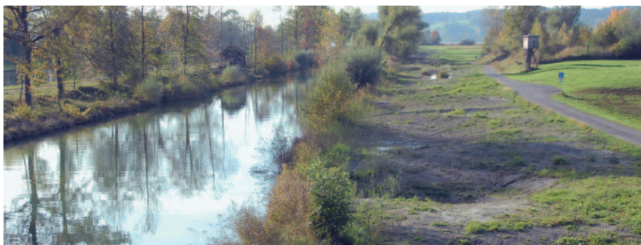
Das Ufer des Seitenkanals der Linth wurde renaturiert.
